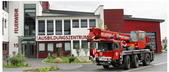
Das Ausbildungszentrum (Foto Feuerwehr)
