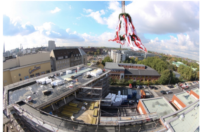
Der Richtkranz über der neuen Wache Foto: Foto 112
